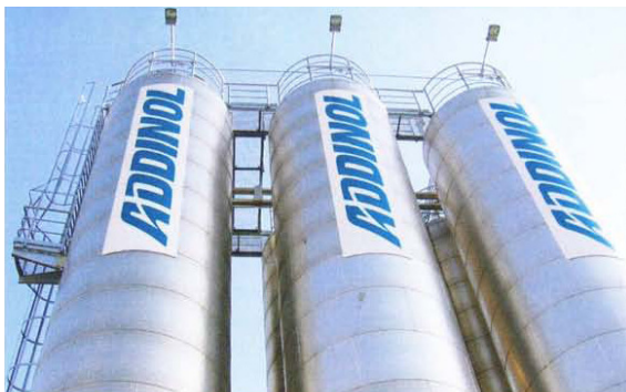
Imposantsed tsisternid: Addinol Lube Oil GmbH väliladu.
