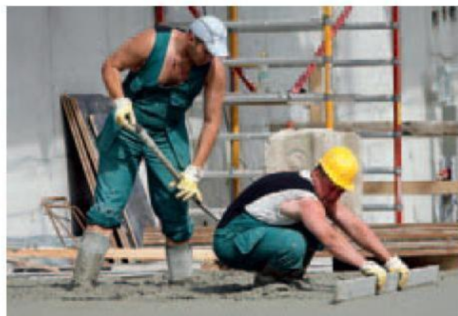
BETONEERIMISEL on tähtsad õiged töövõtted.
