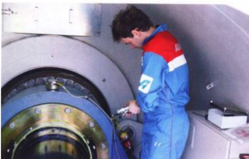
На высоте ветров: менеджер по производству Штеффен Хомберг за работой в гондole Фото: ADDINOL
